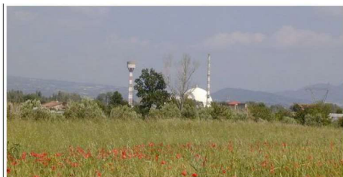
Centrale Nucleare del Garigliano - CE
